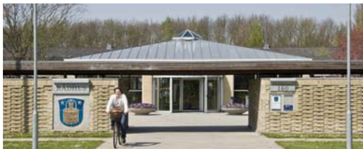
Brøndby Rådhus af Svend Eske Kirstensen er opført i perioden 1957-75.
